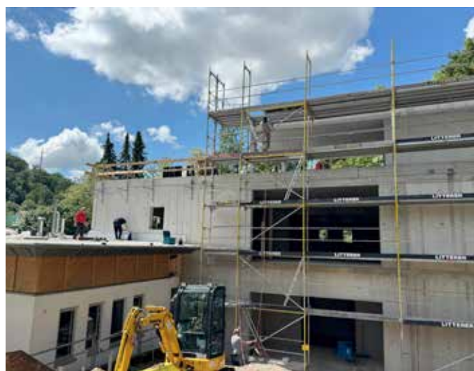
Technologiezentrum mit Anbau, Stand April 2024
